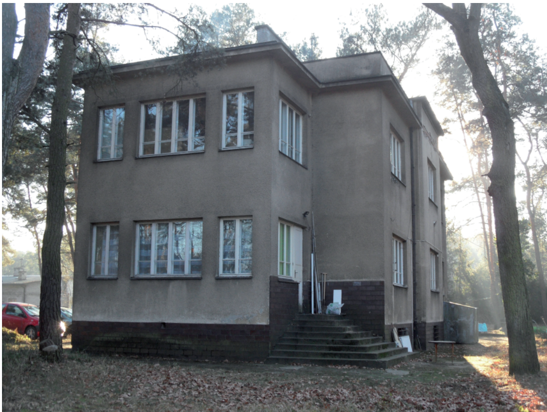
Ilustracja 8. Otwock, ul. Wąska 10/12 — widok ogólny budynku. Fot. E. Popławska-Bukało, 2018
