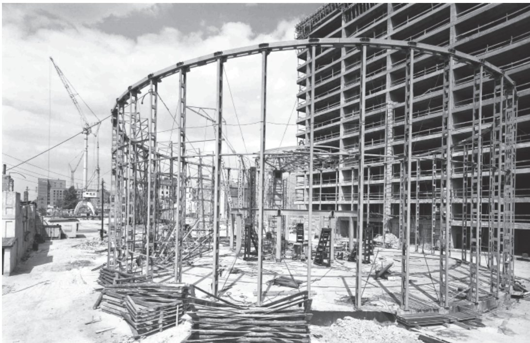
Ilustracja 20. Warszawa, ul. Marszałkowska, tzw. Strona Wschodnia, szkielet stalowy Rotundy PKO, w tle biurowiec „Universalu” w budowie, generalny projektant Strony Wschodniej Zbigniew Karpiński, architektura i wnętrza Rotundy PKO Jerzy Jakubowicz, ok. 1960 (główne prace projektowe), 1962 (projekt techniczny Rotundy PKO), fot. Zbyszko Siemaszko, 1963, NAC, sygn. 3/51/0/12.4/532
