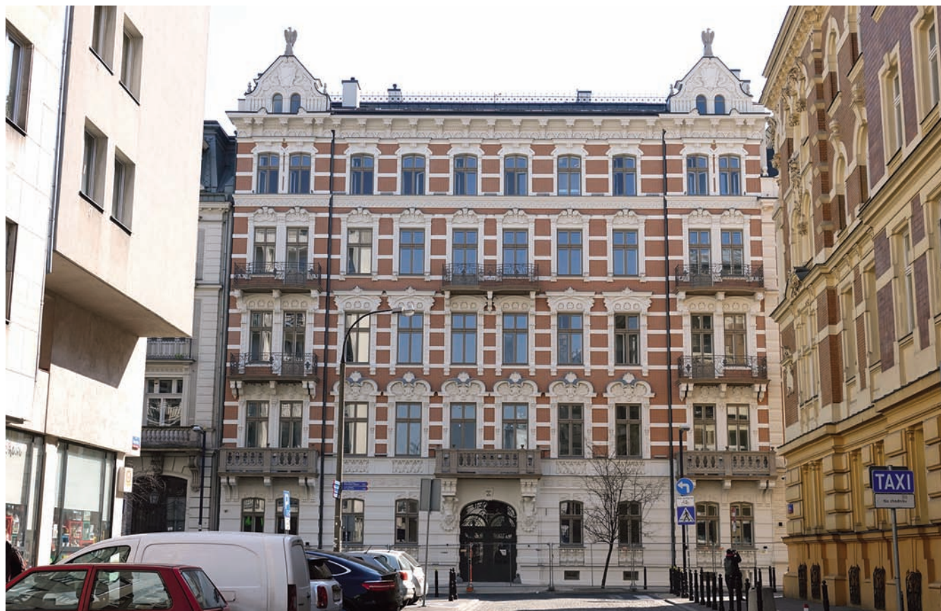
Ilustracja 23. Budynek przy ulicy Foksal 13 ze zrekonstruowanym wystrojem i wyposażeniem stałym elewacji — stan w maju 2021 roku. Fot. P. Kilanowski
