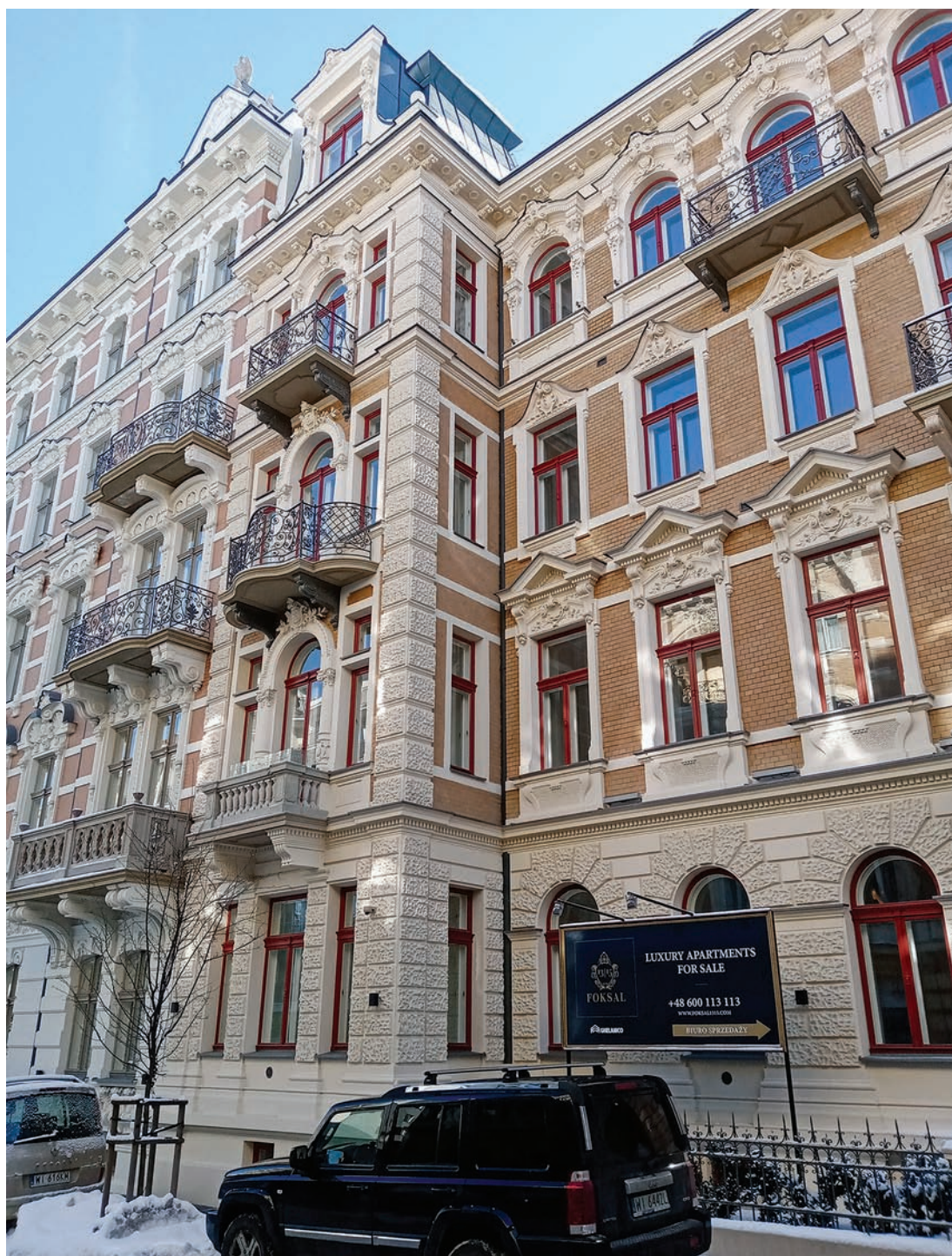
Ilustracja 9. Kamienica przy ulicy Foksal 15, fragment elewacji frontowej ze zrekonstruowaną facjatką wieńczącą ryzalit oraz kroksztynami wspierającymi gzyms koronujący — stan na luty 2021 roku. Fot. D. Rostkowski
