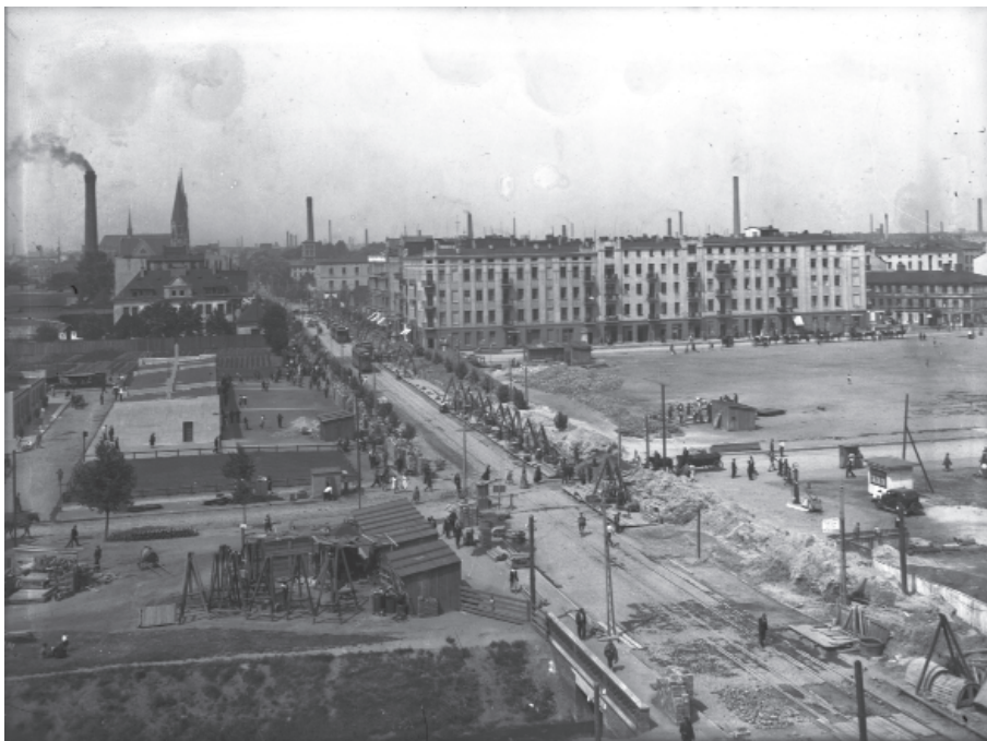
Ilustracja 2. Łódź, budowa kanalizacji w ulicy Piotrkowskiej w rejonie pl. Niepodległości, widok w kierunku północnym. Fot. autor nieznany, 1925–1939, Archiwum Państwowe w Łodzi (dalej APŁ), zesp. Przedsiębiorstwo Kanalizacja i Wodociągi w Łodzi, sygn. 689
