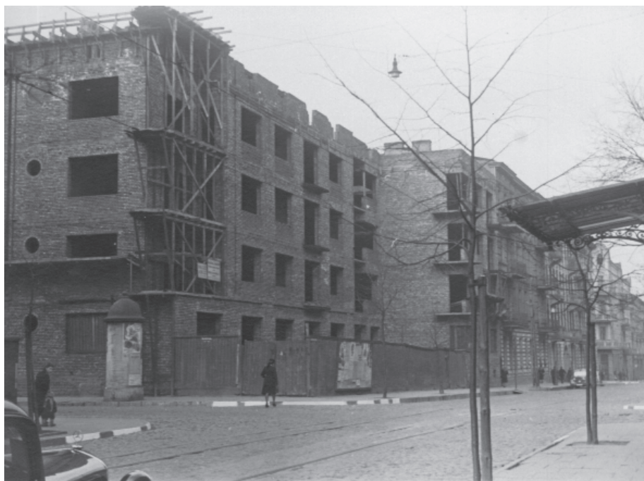
Ilustracja 8. Łódź, ul. Gdańska 39, budowa przerwana w 1939 roku, proj. Izaak Gutman, 1939. Fot. autor nieznany, 1939–1945, APŁ, zesp. Zbiór ikonograficzny APŁ, sygn. 116.4
